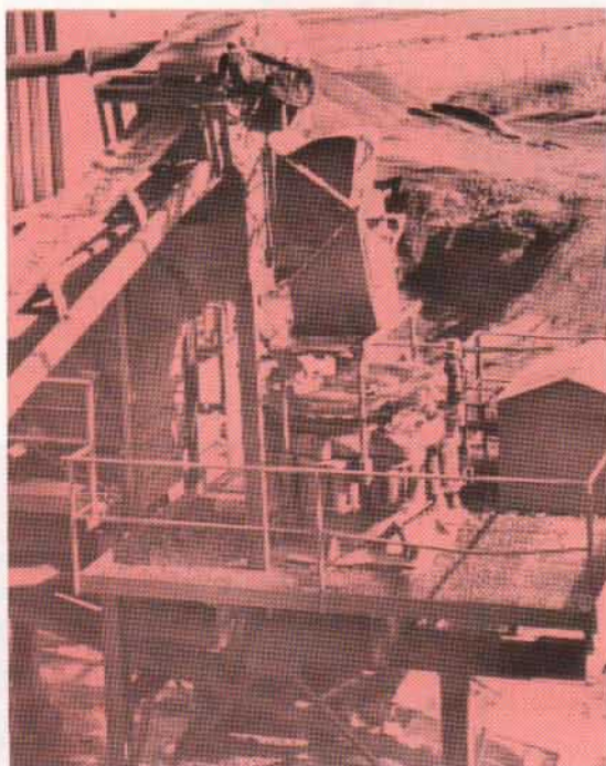
澳大利亞某現場安裝36" 旋盤式破碎機的台架。
